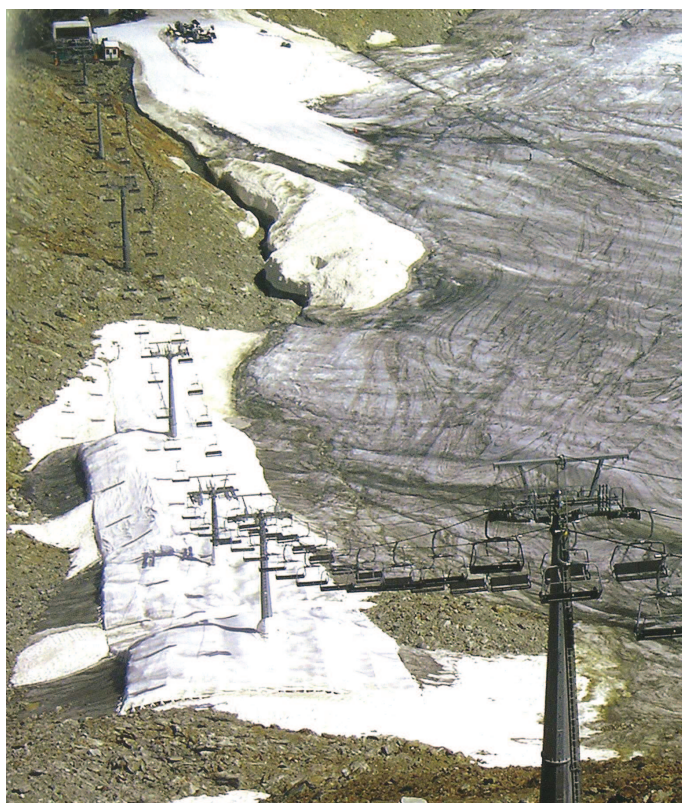
Fig. 3.2: teli geotessili alla base di una "zona nevralgica" sugli impianti di risalita austriaci.
