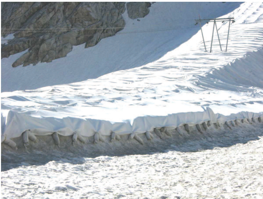
Fig. 4.3 : teli geotessile di copertura alla base dei piloni e della risalita dello skilift al Ghiacciaio Presena (foto M. Donati, luglio 2010).
