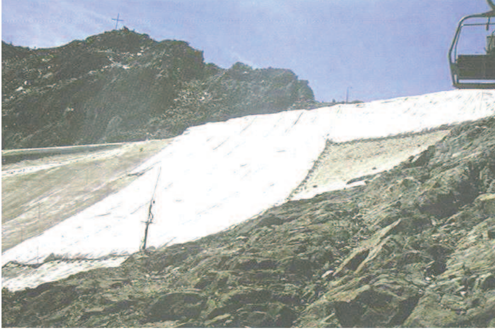
Fig. 3.3: porzione di ghiacciaio austriaco rivestito con teli geotessili.
