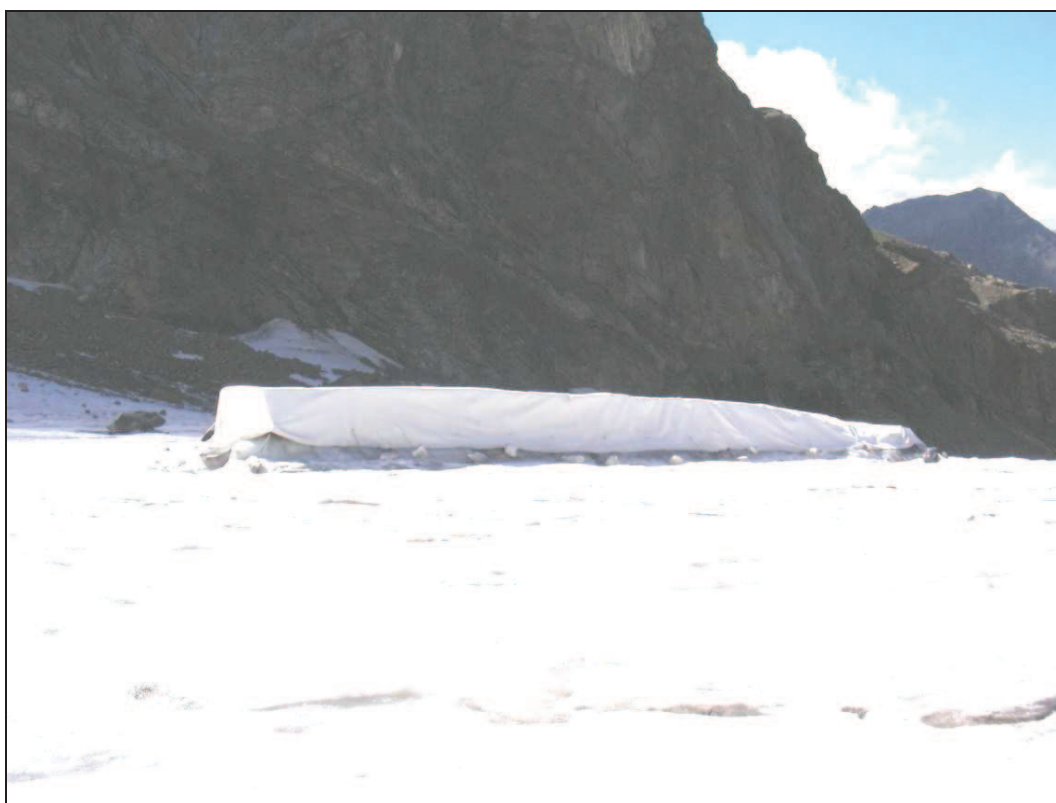
Fig.3.2: notevole effetto positivo ottenuto grazie alla copertua con geotessile e risultato finale con spessore di neve preservata dalla fusione
