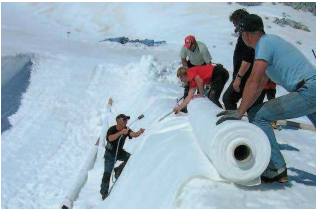
Fig. 4.2: operai impegnati nel posizionare i teli e saldarli termicamente fra loro (foto Adamelloski).
