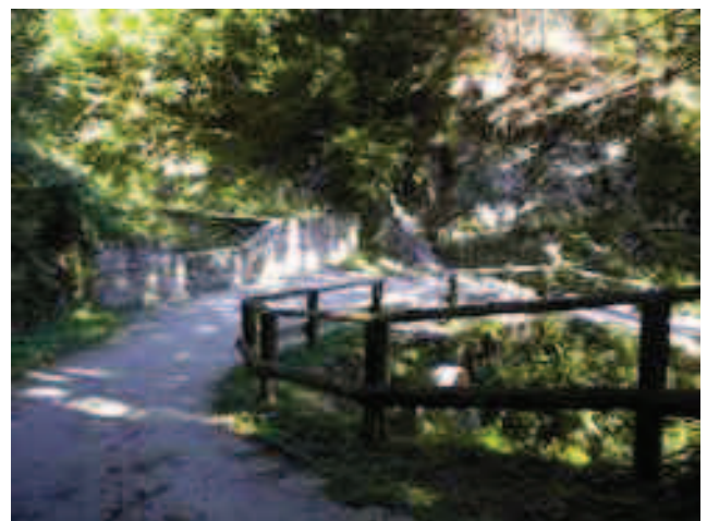
Figura 4.3 – Staccionata in legno
