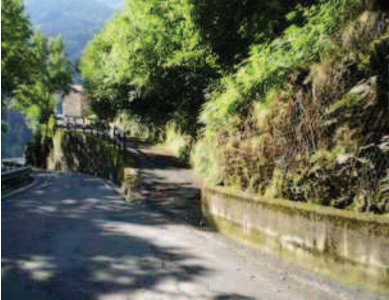
Figura 6.6 – SP 294, in corrispondenza del bivio per Sparsinica
