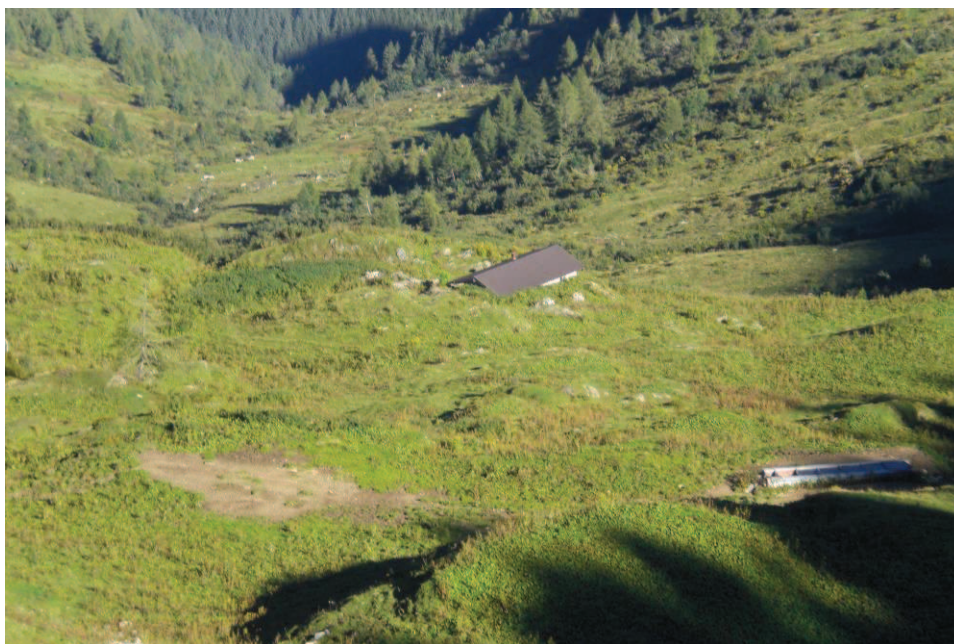
FIGURA 4.5.1: STAZIONE ALTA DI MALGA ERBIGNO
