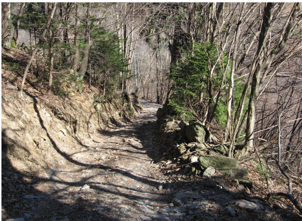
Figura 17: tratto della VASP 01 caratterizzato da una carreggiata molto stretta con possibilità di modifiche
