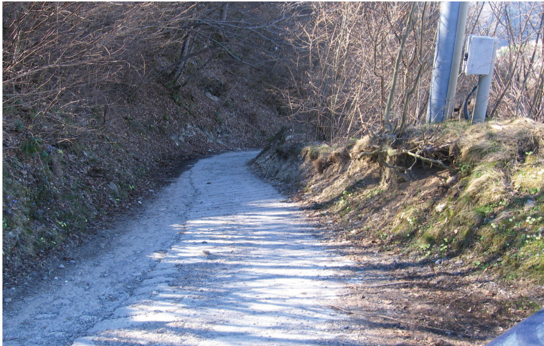
Figura 1: VASP 11 del comune di Bovegno, esempio di strada con forti pendenze
