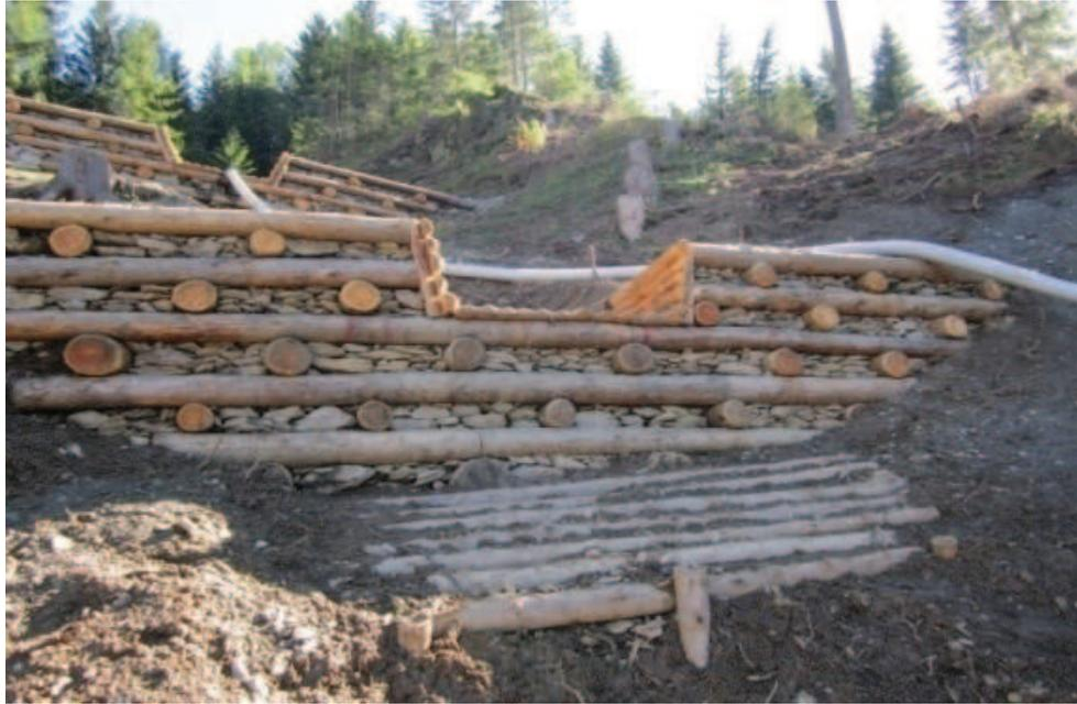
**Figura 11** Briglia in legname e pietrame con dissipatore in legname.
