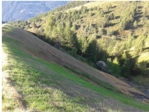
**Figura 8 Inerbimento eseguito su pendio acclive tramite posa di reti in fibra naturale ed idrosemina.**
