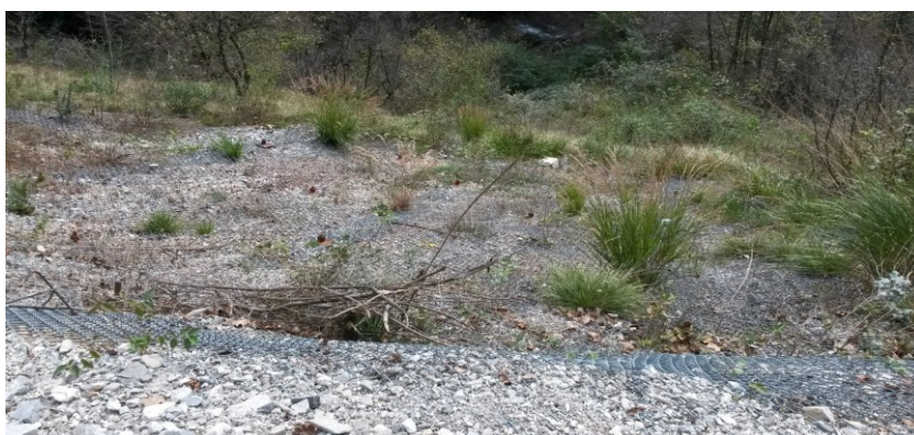
Figura 16 Opera di sostegno alla strada SV94
