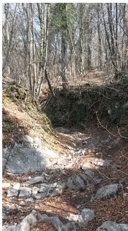
Figura 9 Sentiero C.A.I. 388 erosione del sentiero a causa di acqua e motocross
