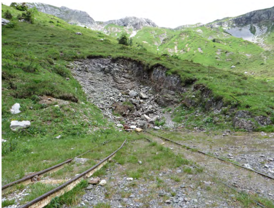
Figura 7: Cava di barite chiusa per sicurezza in località Pagherola
