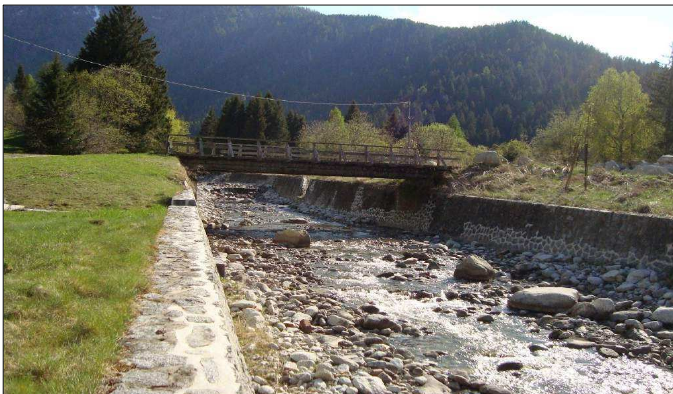
Figura 3.4: Opere longitudinali di difesa spondale presenti su entrambe le sponde del rio, nella zona di confluenza con il torrente Vermigliana. Fonte: Archivio personale
