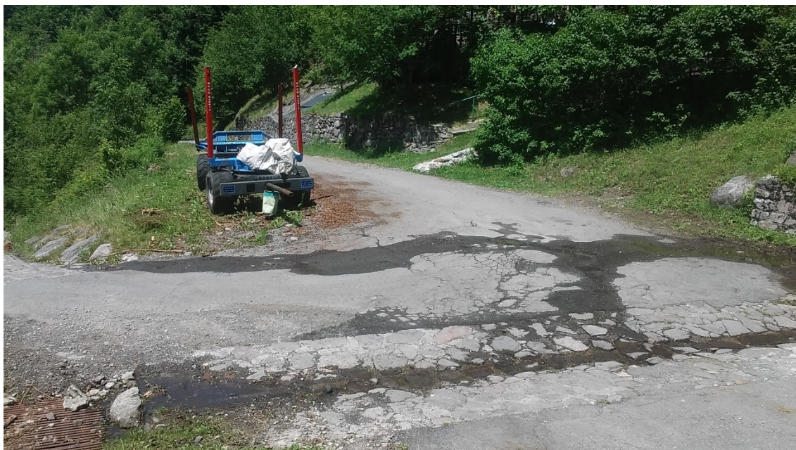
Fig.18 L'imposto camionabile nei pressi del Ponte di Sesa, da qui la zona di taglio dista 7 km.
