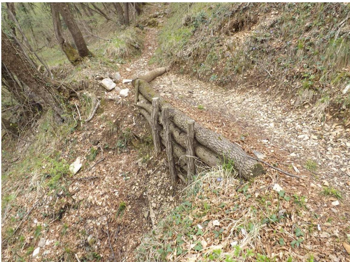
*Figura 10 - Opera di sostegno al sentiero, realizzata con materiali non idonei a garantire una durabilità nel tempo dell'opera stessa*
