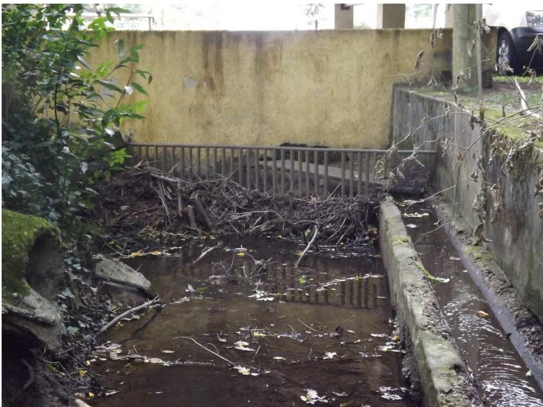
*Figura 24 - Griglia selettiva all'imbocco della canalizzazione sotterranea alla strada*
