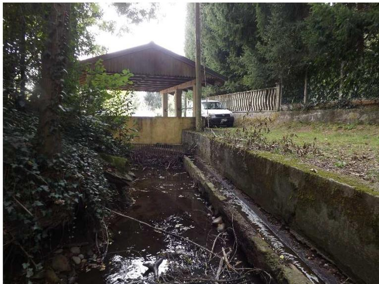
*Figura 21 - Opere di canalizzazione dell'acqua che permettono l'alimentazione del lavatoio*
