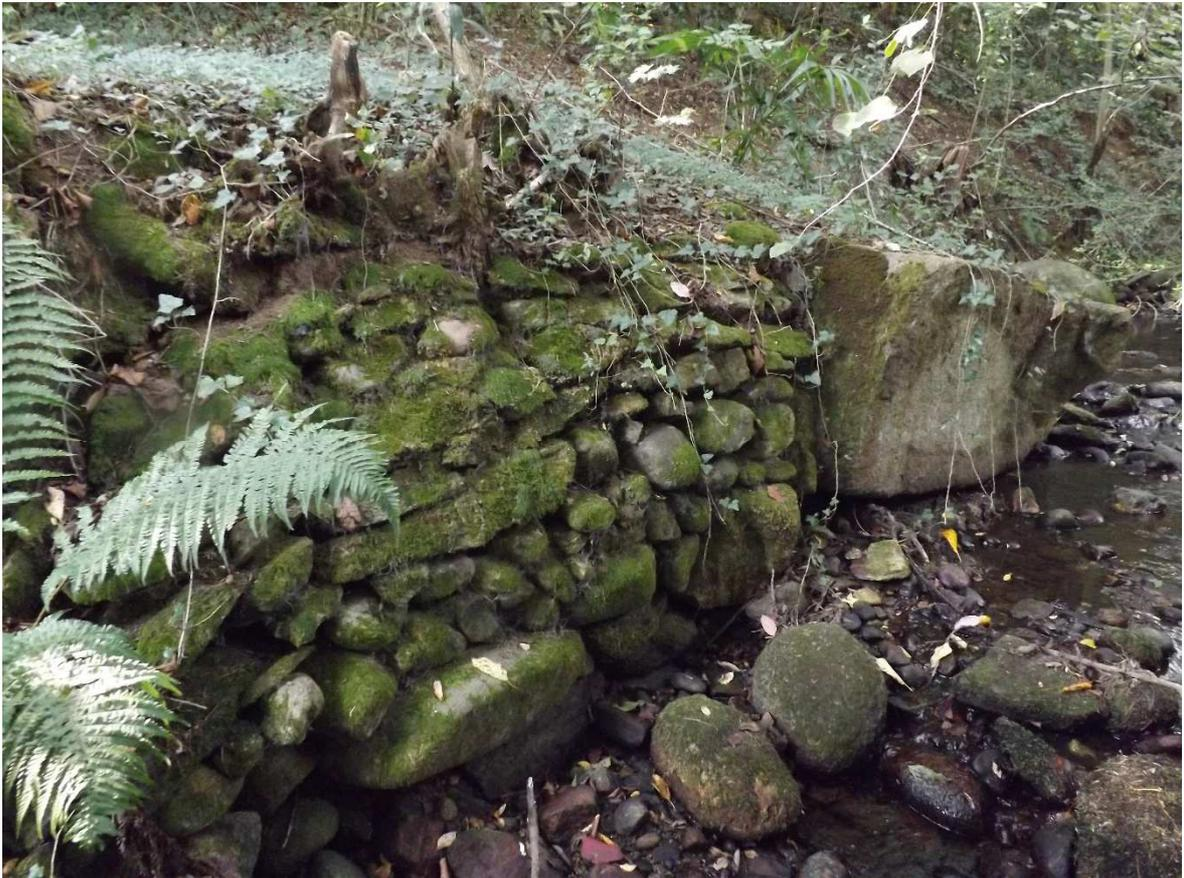
*Figura 16 - Muro a secco presente sugli argini del torrente Donda, ormai in condizioni precarie*
