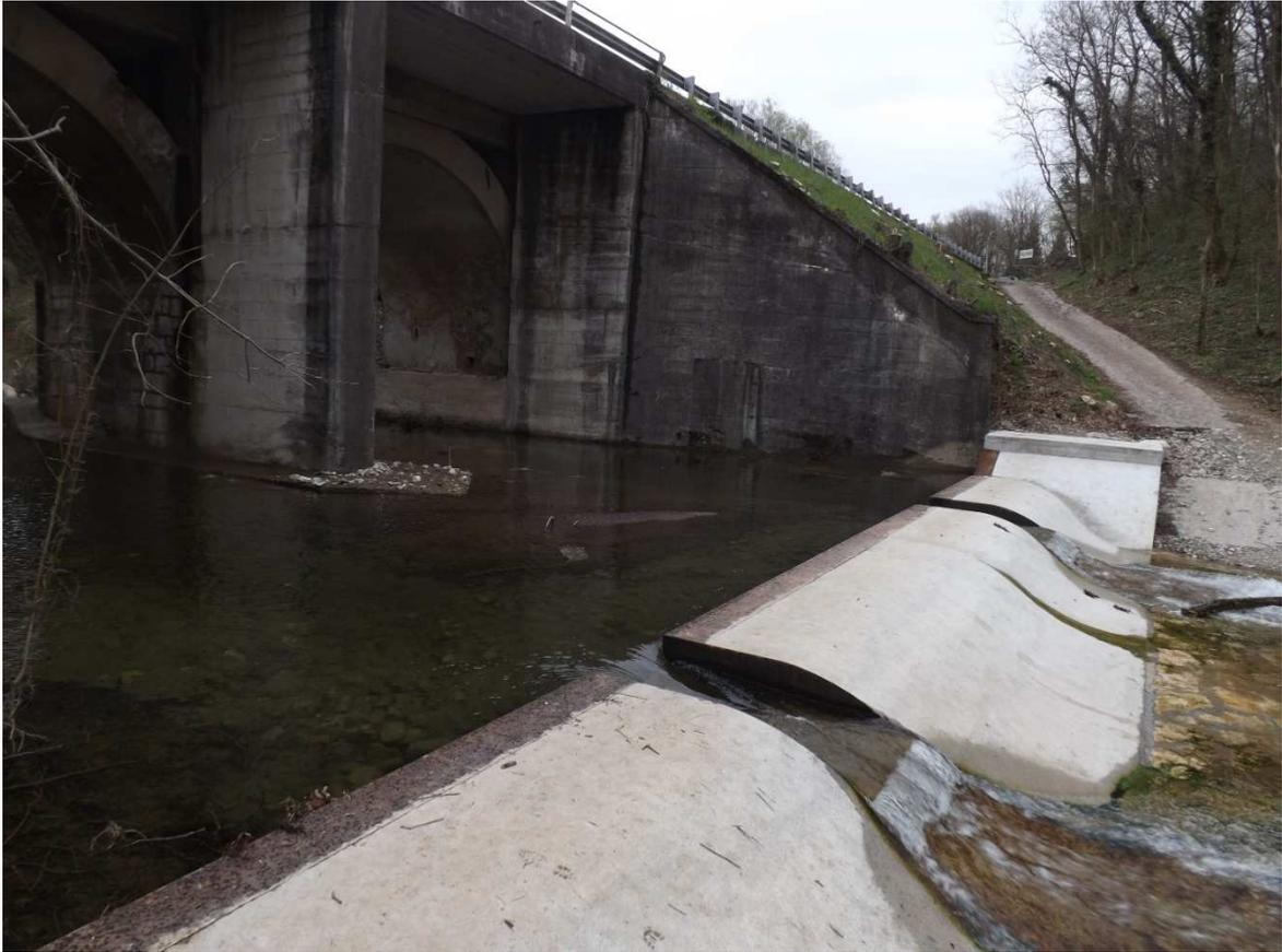
*Figura 27 - Briglia sinusoidale. Visibile l'abbassamento del livello idrometrico in corrispondenza dello stramazzo dall'opera, punto di transizione da corrente lenta a corrente veloce*
