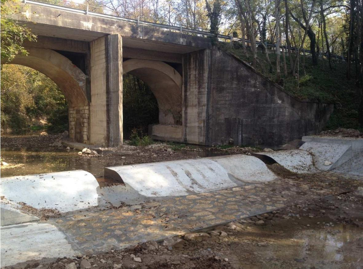
*Figura 28 - Opera ultimata. Da notare il guado rivestito in pietrame*
