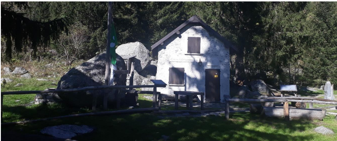
Figura 78. Il centro informazioni dei Bagni di Masino.
