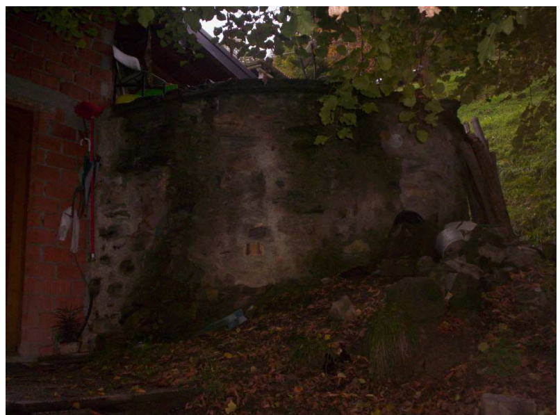
Figura 56. Partic. nevèra a base circolare
