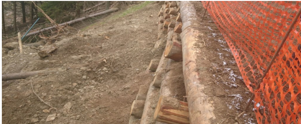
Fig. 38 - PONTE DI LEGNO: palificata doppia al Recinto faunistico (2018)
