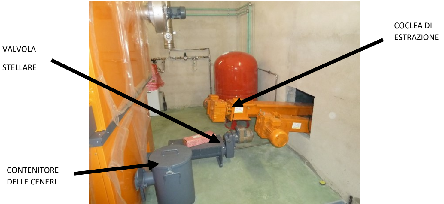
Figura 14: Coclea di estrazione del combustibile con annessa valvola stellare.
