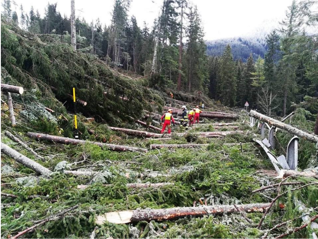
Figura 7. Rimozione di alberi abbattuti su una strada in trentino da parte dei vigili del fuoco. (da www.ninbus.it )
