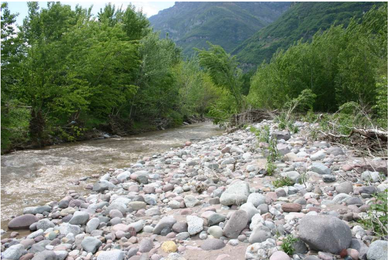
Figura 1- Fotografia risalente a gennaio 2019 che ritrae un tratto del t. Grigna prima che venisse effettuato il taglio. È possibile notare la presenza di materiale in alveo e di materiale vegetale vivo e morto lungo le sponde.
