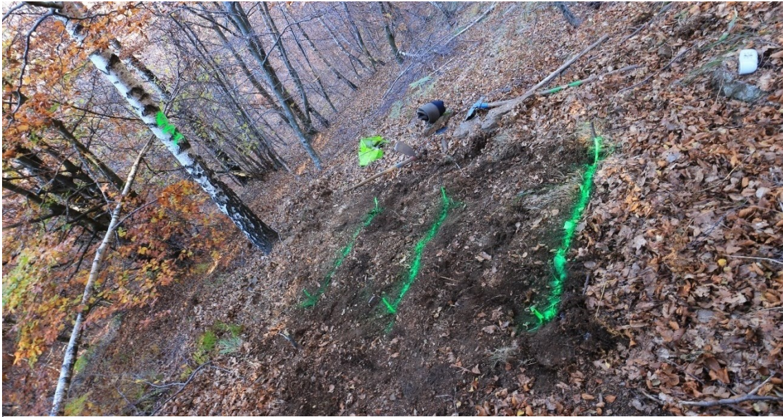
Figura 14 – Misurazione delle tre distanze per le trincee e pulizia dell'area
