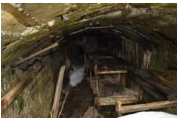
*Figura 12- Interno di una caverna in calcestruzzo austriaca con ancora i letti dove alloggiava la truppa.*
