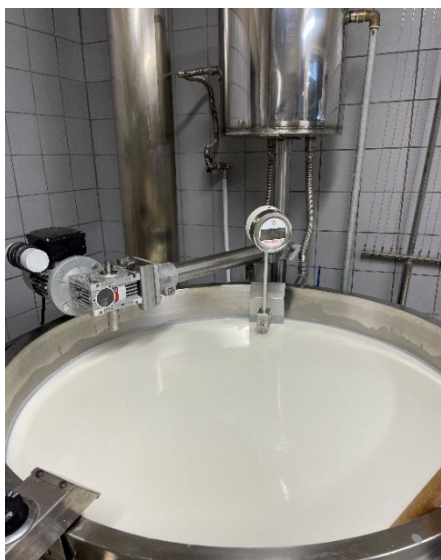
Figura 4: Caldaia in acciaio inox.
