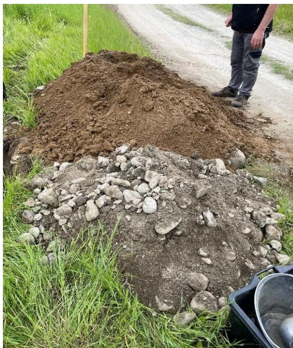
*Figura 8 e 9: Apertura della trincea mediante escavatore meccanico e separazione dei due cumuli*
